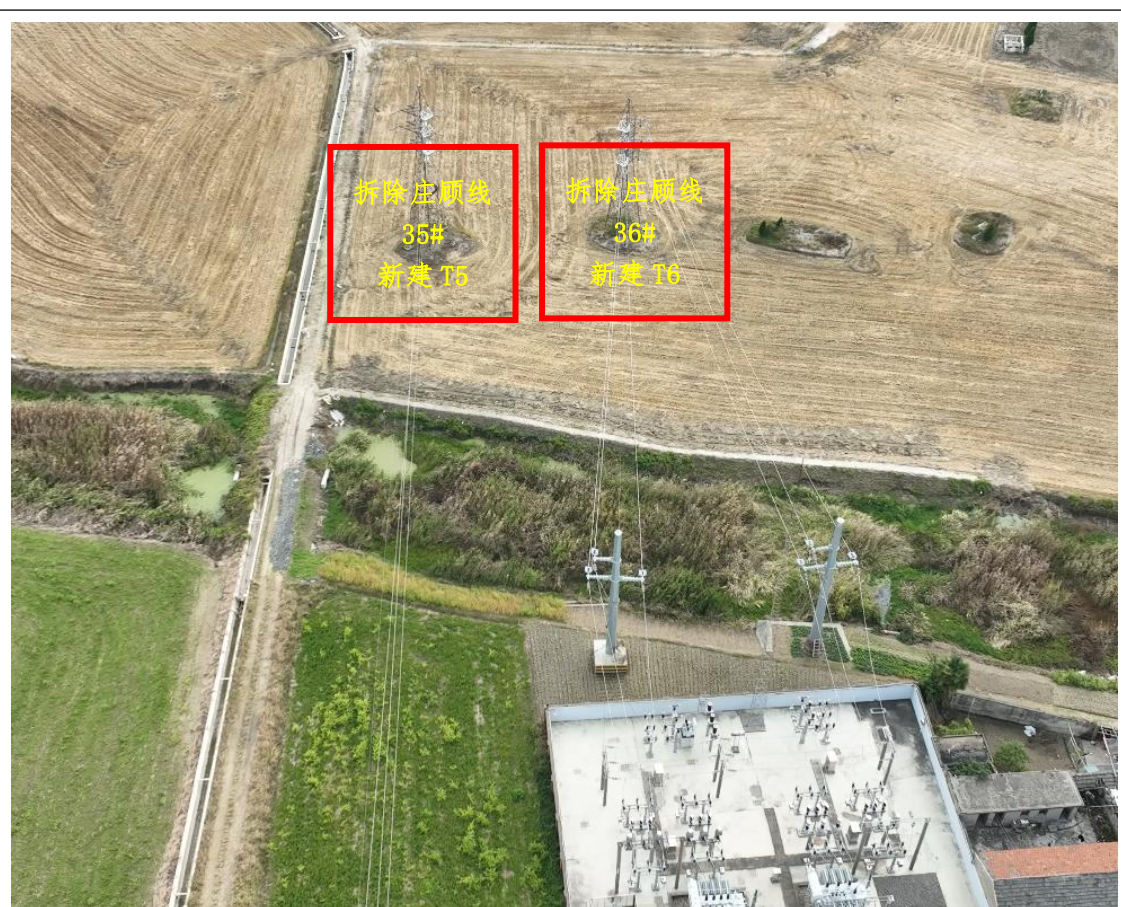
图 1.1-7 本项目现状原地貌（拍摄时间 2024 年 12 月）
