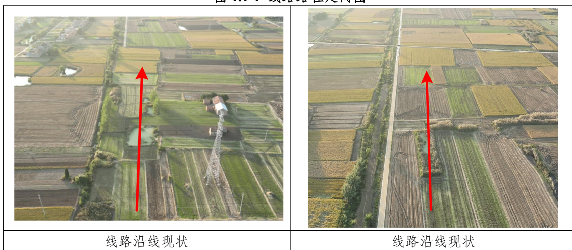
图 1.1-2 本工程线路沿线现状照片
