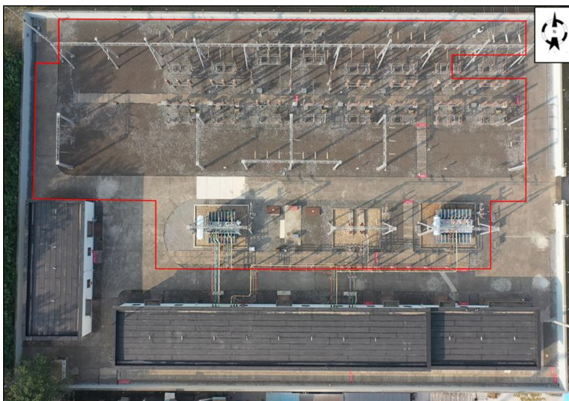
图 1.1-3 泰州堡东 110 千伏变电站改造工程站址现状（红线框为改造区域）
