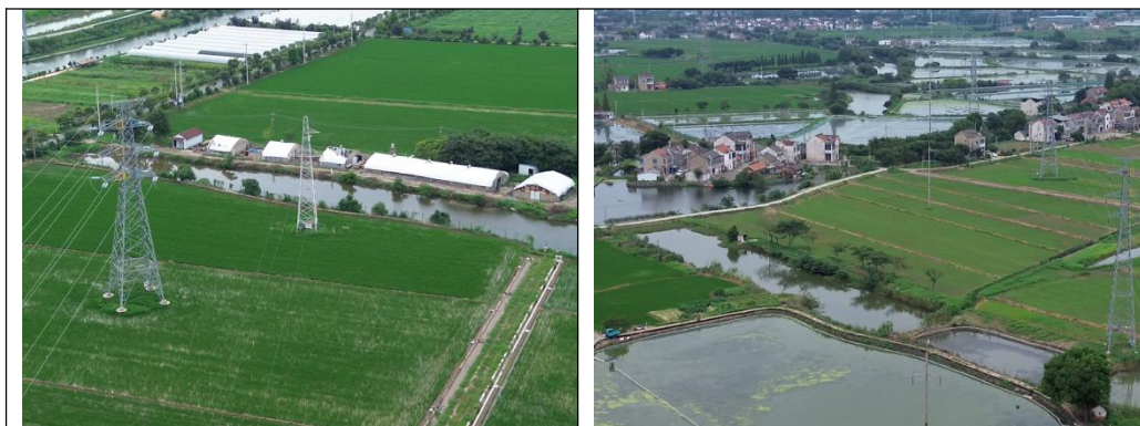
图 1 本项目周围环境现状照片
