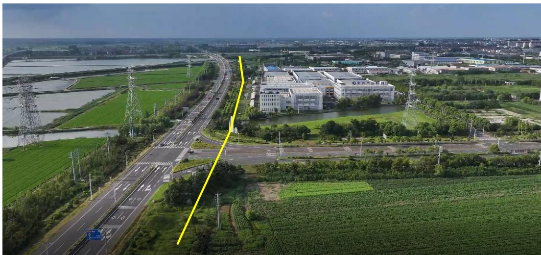
图 1.2-2 沿线地貌（南北向 1）
