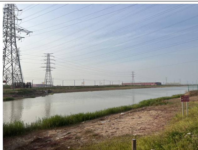
220kV 徐景 4E95 线一档跨越朱圩干河
