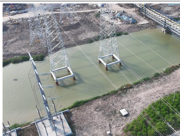
220kV 徐景 4E95 线、220kV 东景 49M0 线在西港河内设立杆塔
