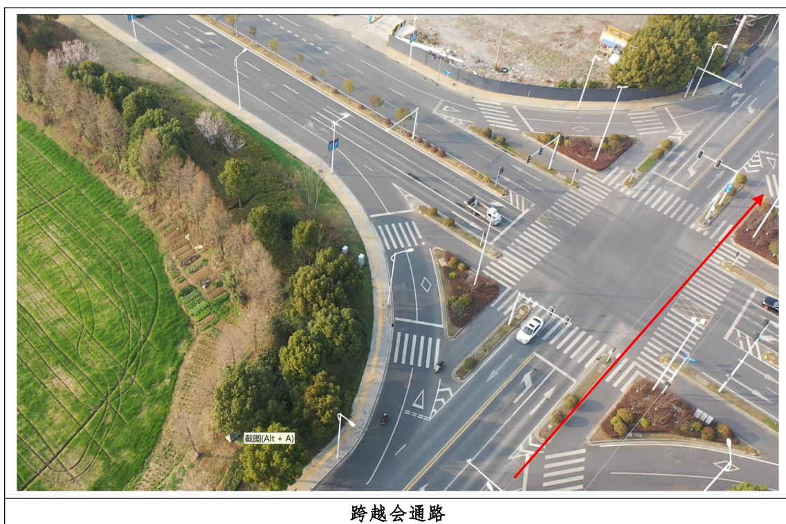
图 1.1-3 本工程架空线路跨越情况照片
