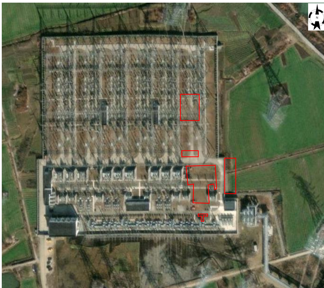
图 1.1-2 本期常州天目湖 500 千伏变电站第四台主变扩建工程现状卫星图 (2023.6)
