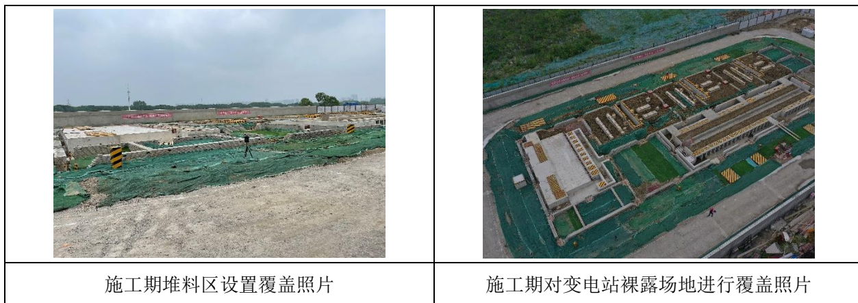
图 8-1 施工期采取的环保措施照片
