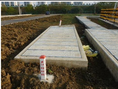
图6-1 本期部分线路采用电缆敷设照片
