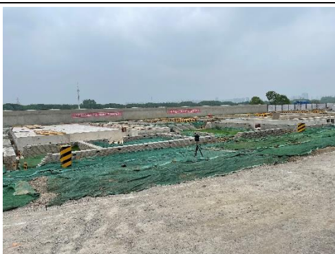
施工期对变电站裸露场地进行覆盖照片
