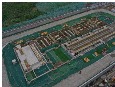
施工期对变电站裸露场地进行覆盖照片
