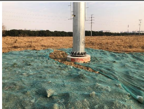
施工期对塔基周围裸露场地进行覆盖照片
