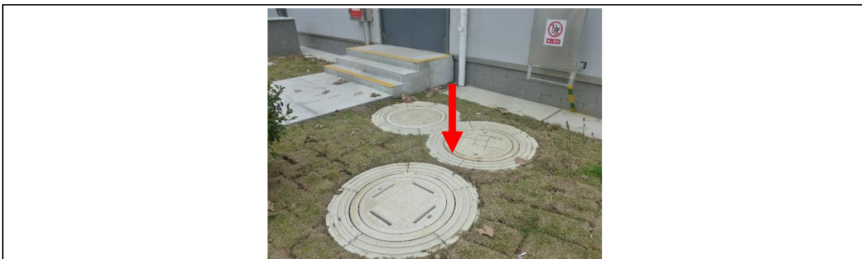
图 8-2 110kV 河东变化粪池照片
