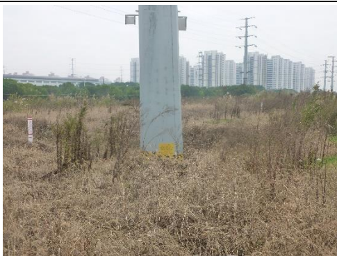
110kV 架空线路塔基周围生态恢复照片
