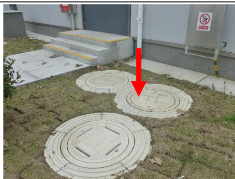
图6-3 110kV河东变化粪池照片
