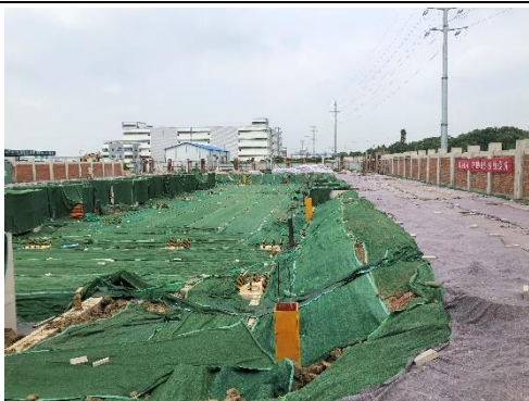
施工期堆料区设置覆盖照片
