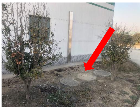
图 8-1 本次验收的变电站化粪池
