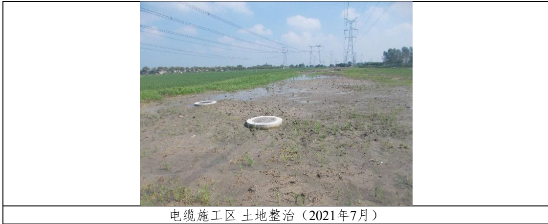
图 4-1 工程措施实施情况
