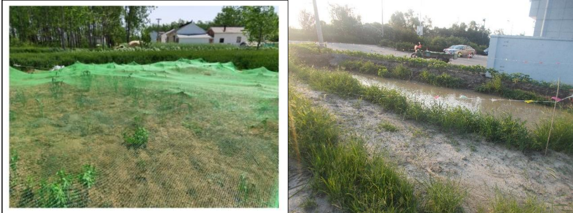
塔基及塔基施工区 密目网苫盖（2021年7月）
