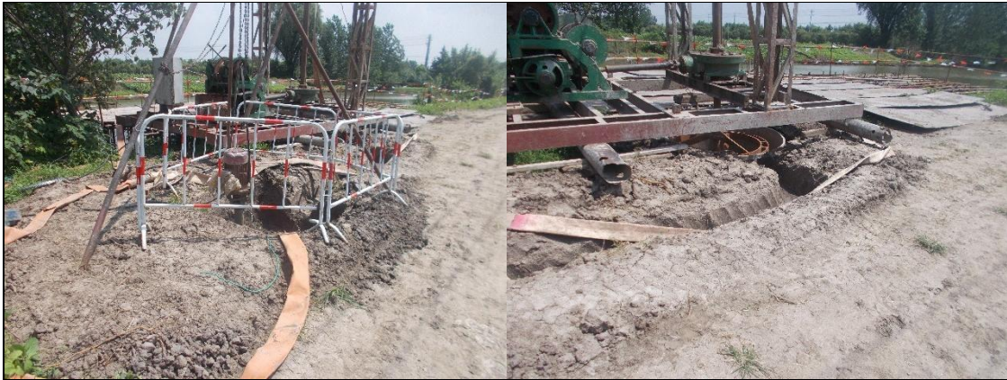
塔基及塔基施工区 泥浆沉淀池、临时排水沟（2021年3月）
