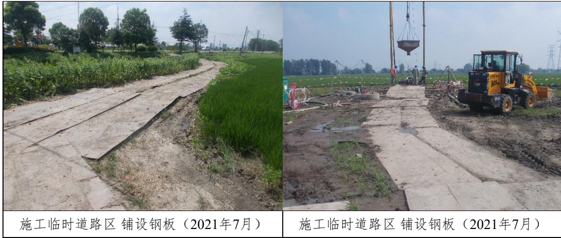
图 4-3 临时措施实施情况
