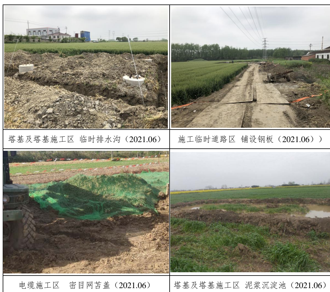
图 4-3 临时措施实施情况
