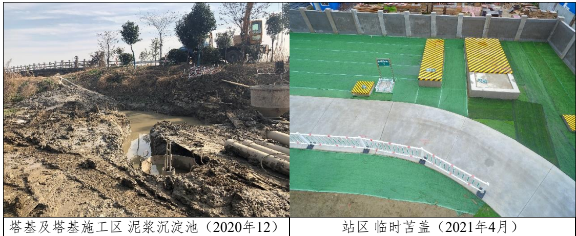
图 4-3 临时措施实施情况
