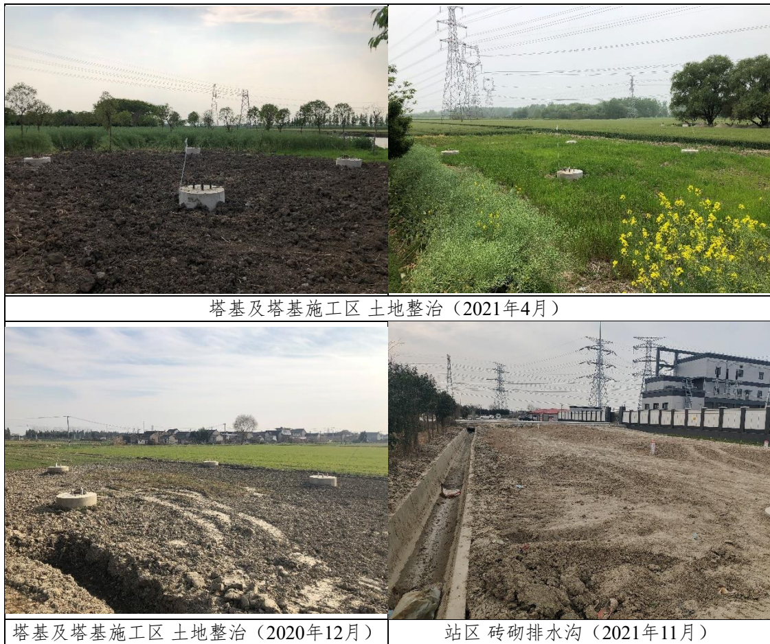
图 4-1 工程措施实施情况
