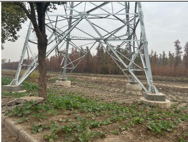
110kV 焦粤 849 线#10 杆塔塔基生态恢复示例
