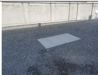
110kV 沿港变电站站内砂石化铺设照片
