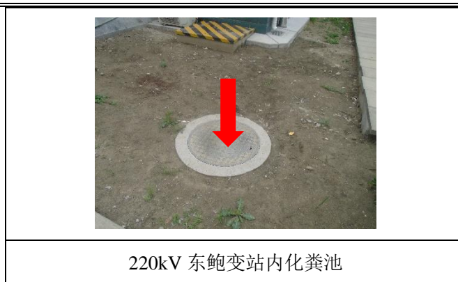
图 8-3 220kV 站内化粪池
