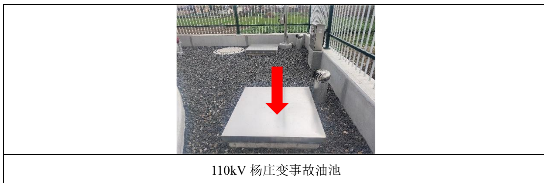
图 8-2 本次验收的变电站事故油池示例
