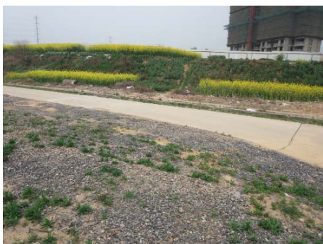
图 6-1 110kV 南江变周围生态恢复示例
