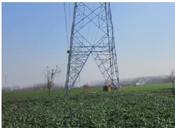
图 8-1 塔基生态恢复示例
